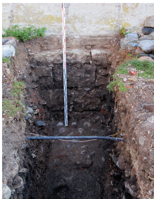
Fig. 5. Two different wall textures discovered at the south-western side of the main castle (excavation XIV). On the right, the transition on the southern corner of the Konventhaus from the quadrate corner of the lower part to the rounded one in the upper part can be seen. The ground under the measuring rod remained on the same level still in the 17th century. Jn 5. Pealinnuse edelaküljel (kaevandis XIV) paljastunud kaks erinevat müüri faktuuri. Paremäl on näha konvendihoone lõunanurga üleminekut kvadraatselt alaehitiselt ümardatud nurgaga seinäosaale. Mõõtelati alla jääv maapind püsis samal kõrgusel veel 17. sajandil.
