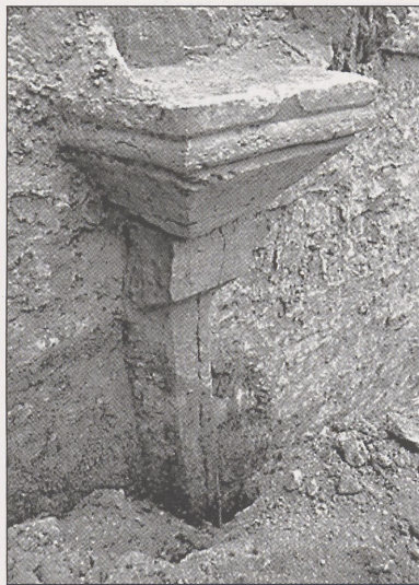
Fig. 4. Pühavaimu 6 / Vene 11: Hewn limestone pilaster in the medieval ruin.
