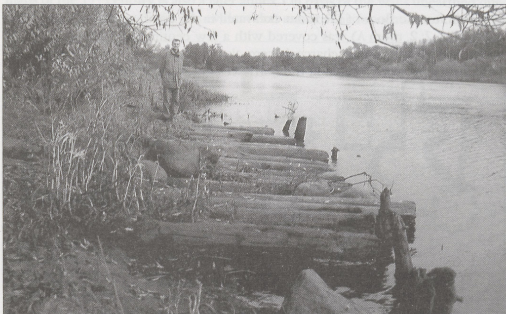
Fig. 4. The raft foundation of the round tower of Varbek castle at the bank of River Emajõgi. Joon. 4. Varbeki linnuse ümartorni alusparv Emajõe kaldal.
